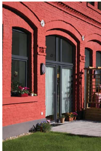
Tidigare industri-områden kan omvandlas till bra miljöer för bostäder och/eller verksamheter, som här i Aachen. Källa: "Umnutzung von alten Gebäuden zu Wohnzwecken", Ministerium für Bauen und Verkehr NRW 2008 Foto: Hans Jürgen Landes.
