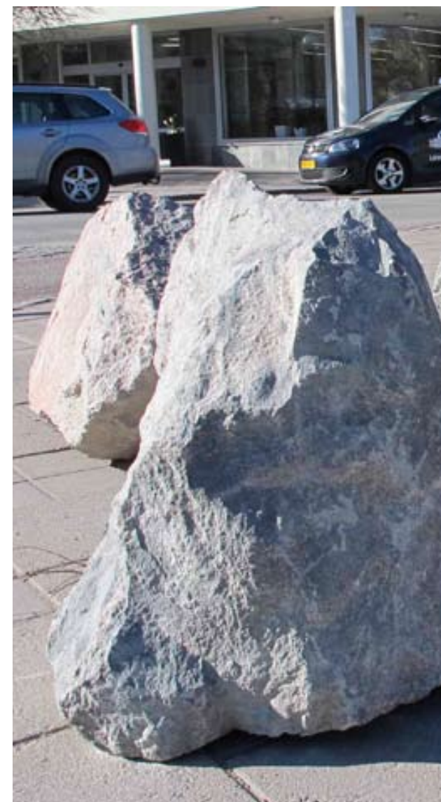
Ojäмна, spetsiga kanter på skutblocken
