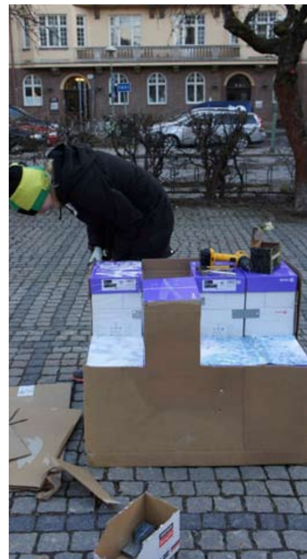
Kartong fästes runt kartongerna för att öka stabiliteten, Bitte Andersson
