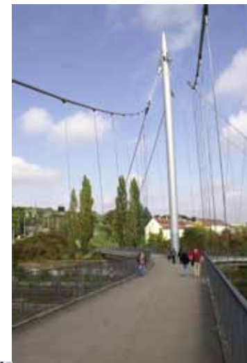
(T.h.) Den här hängbrons konstruktion kändes lätt.
