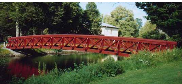
Exempel på fackverksbro, Ronneby
