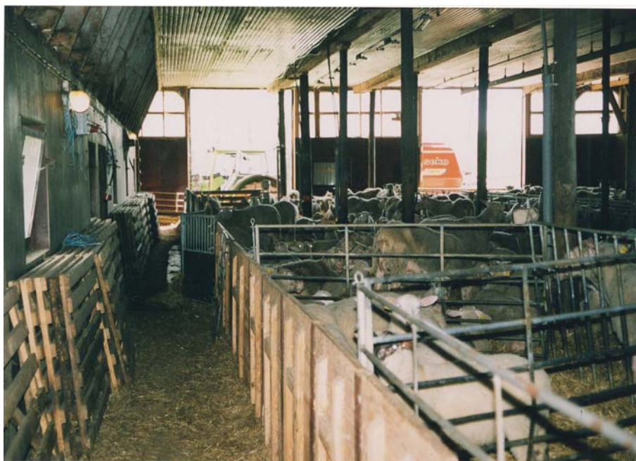
Figur 11. Bilden visar inspektionsgången längs med ena stallväggen. Att taket är höjt ser man också uppe till vänster i bilden. I gången står hemmabyggda trägrindar.
