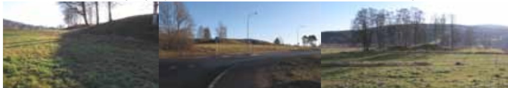
Gräsklädda kullar - Överskottsmassor används till att bygga upp kullar, mellan 0,75 m - 2 m höga.
