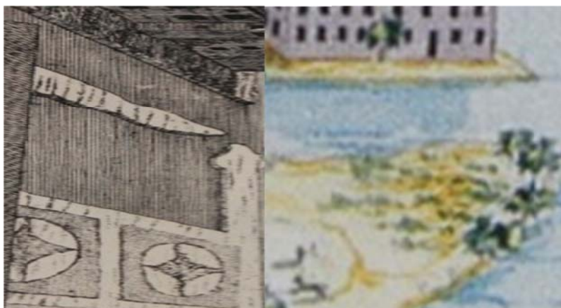
Bild 11/12: Fram till 1700-talet låg slott och trädgård mitt emot varandra, med endast vallgrav och en damm som skiljde dem åt (vänster bild). Under 1700-talet ändrades detta: på dammens och två av barockparterrerornas plats anlades en ridbana, varav den runda longerings-bana som återges i höger bildens nedre vänstra hörn, anlades på den vänstra av parterrerorna.
