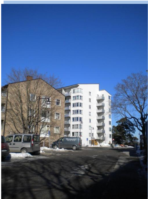
Bild 4: Nyckeln med äldre 3-våningshus i förgrunden och nyare 8-våningshus i bakgrunden
