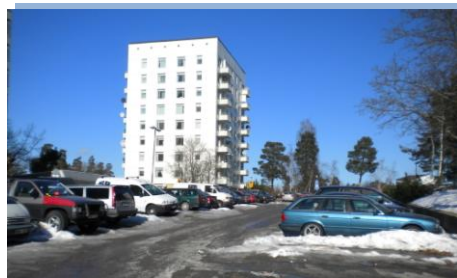
Bild 2 Parkering på Ervallakroken
