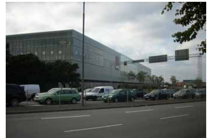
Fig. 32 överst: Den inglasade gångbron mellan Entrés två byggnader Glashuset (t.v) och Torghuset (t.h.)
