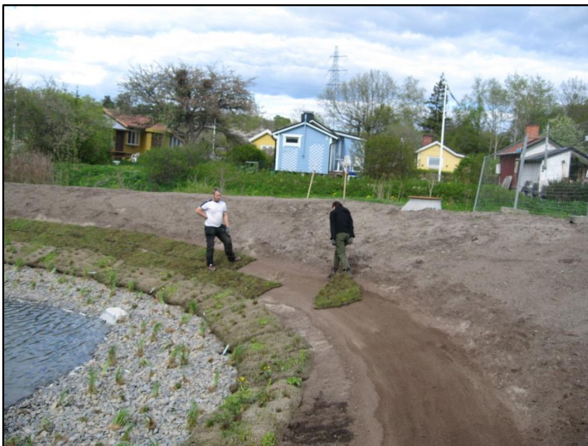
Figur 13. Bilden visar anläggningen av en damm i skarpnäck där vegetationsmattor ska skydda mot erosion. Foto Veg Tech
