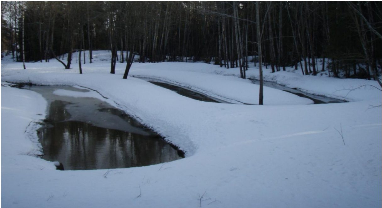
Figur 21. Myrsjödammen, till vänster på bilden syns inloppet. Längst ner på slänterna har erosion uppstått.
