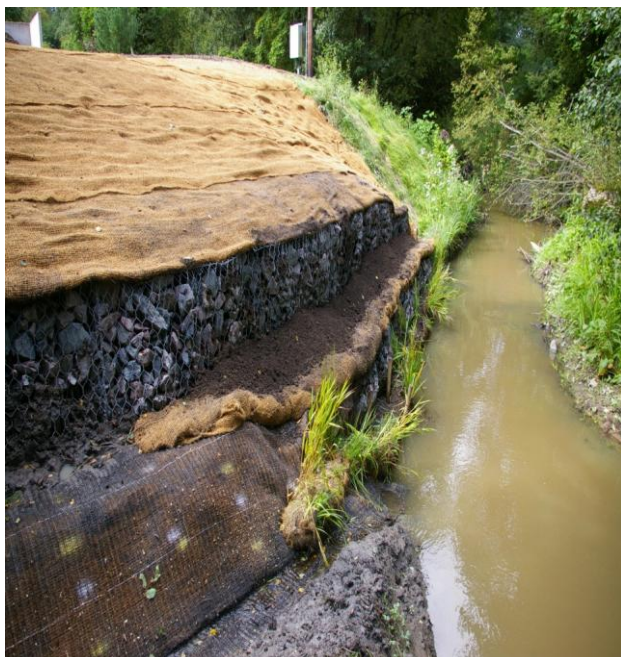
Figur 17. Gabioner har använts som erosionsskydd. Källa och rättigheter THULICA AB.
