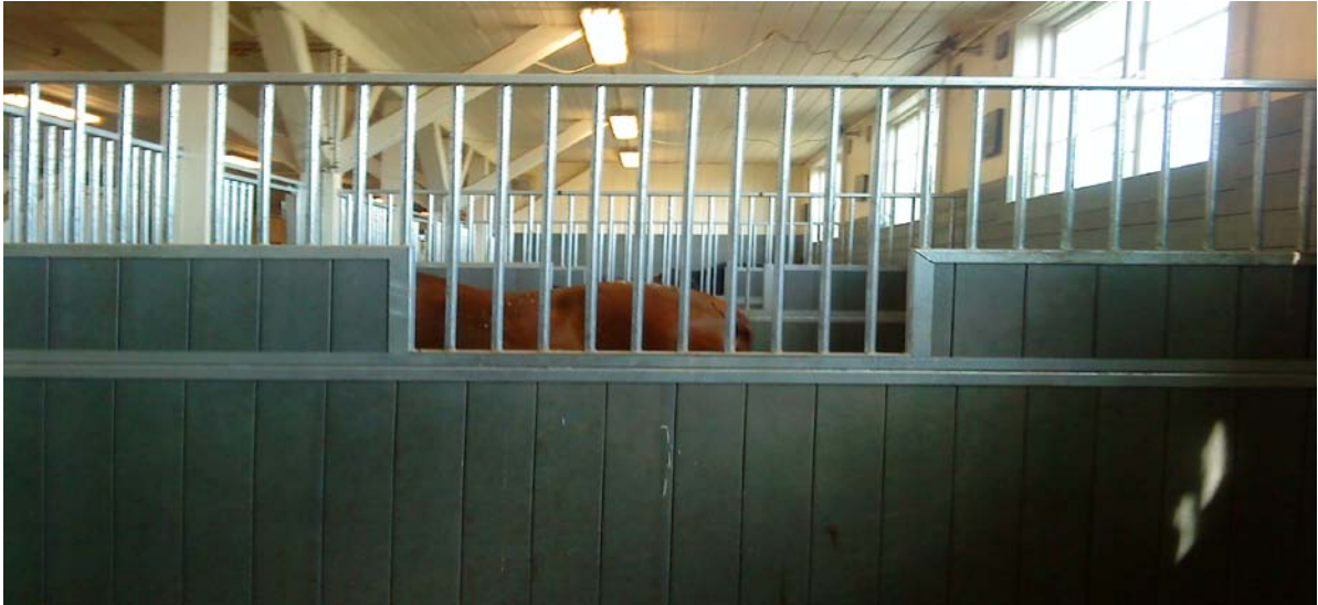
Bild 1. Boxväggarnas mittendel när behandlingar är öppna. Med försatta skivor som skiljevägg blir behandlingen stängd.
