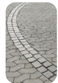
fig. 38 & 39 Friser av flammad gatsten i betong-läggning
