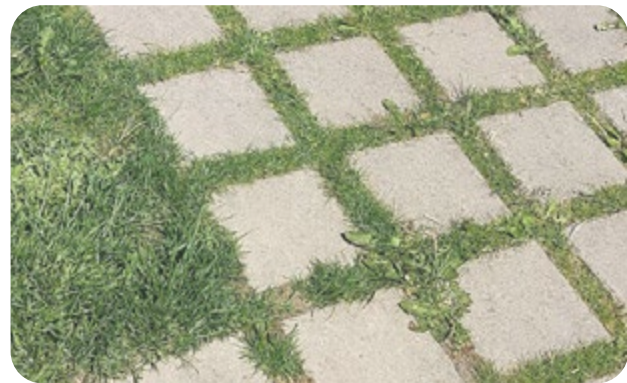
fig. 49 Betongarmerat gräs på parkeringsytor för bättre genomsläpplighet.
