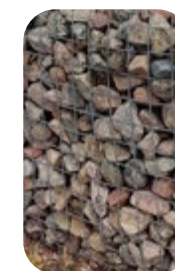
fig. 40 Gabioner fyllda med sten för bänkar och murar
