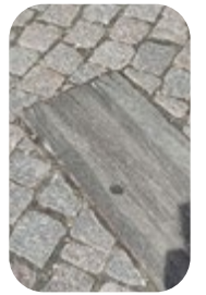
fig. 33 Träplank i marksten vid utsiktplats
