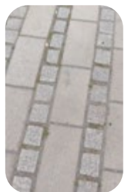
fig. 38 & 39 Friser av flammad gatsten i betong-läggning
