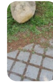
fig. 30 Betongarmerat gräs till parkeringsytor
