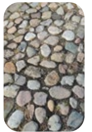
fig. 36 Kullersten och smågatsten vid kurvor och runt detaljer.
