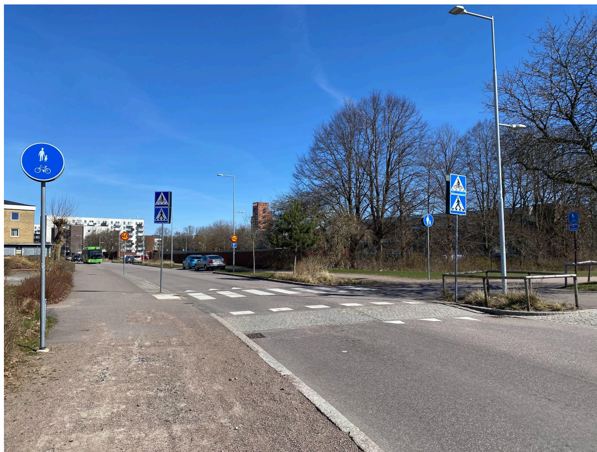
Figur 12. Hastighetssäkrad överfart där gc-banan byter sida av vägen. I samband med att ytan byter användningsområde så ändras underlaget från grus till asfalt.
