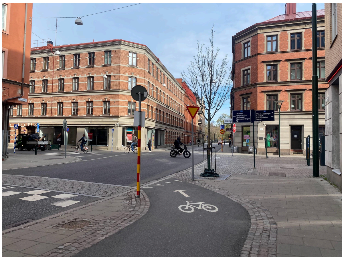
Figur 5. Cykelbanan på västra sidan upphör och cyklister leds in i korsningen Davidshallsgatan/Storgatan.
