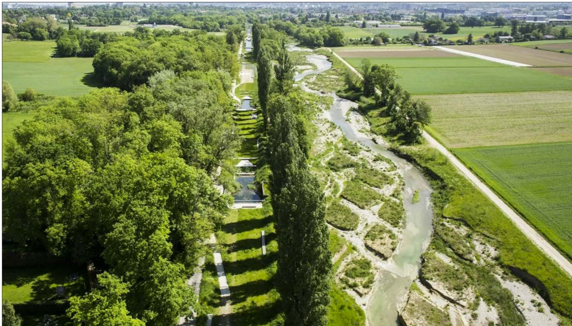
Figur 15. River Aire: Omvandlad kanal och ny flod. Foto: Fabio Chironi. Källa: FOEN (u.å)
