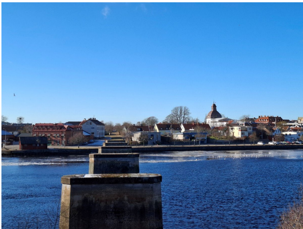
Figur 12 Vy från andra sidan ån, sett mot området. Egen bild
