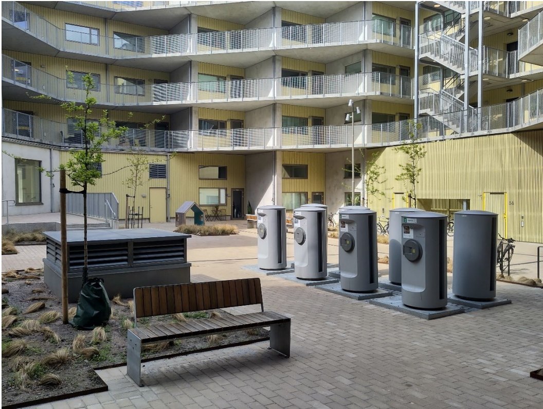
Figur 14 Fastighetens innergård med sopnedkast och den tekniska anläggningen i förgrunden (Egen bild).
