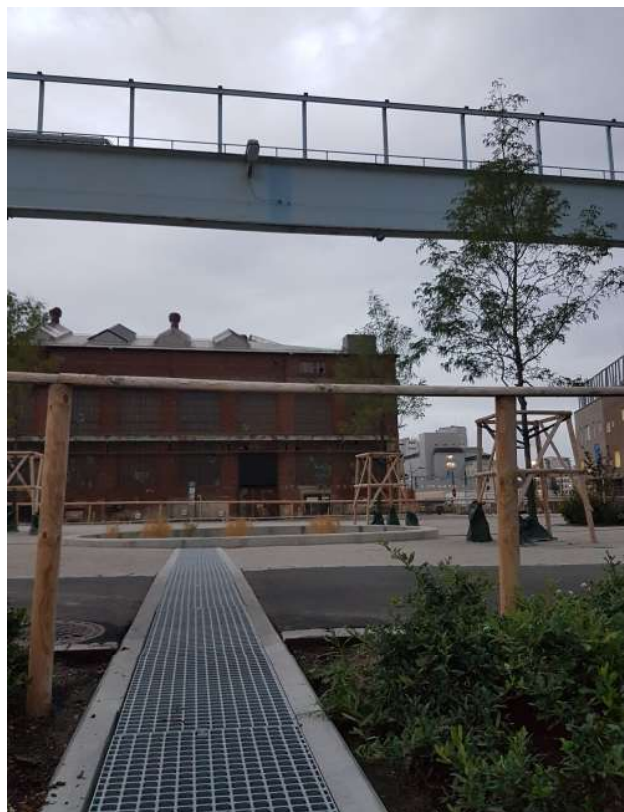
Figur 11. Lång dagvattenränna från gatumark till biofilter, Einar Hansens esplanad Malmö. Augusti 2020.
