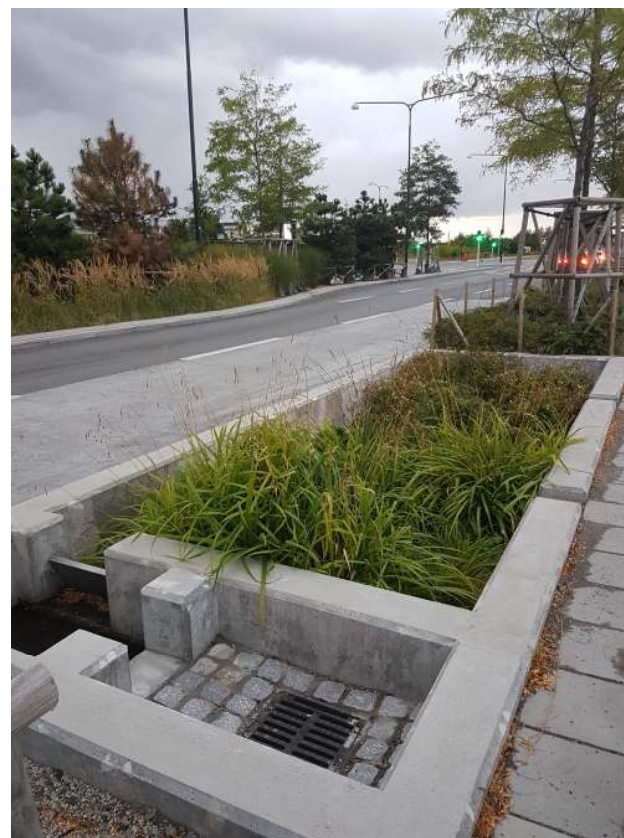
Figur 12. Biofilter i väggkant, Neptunigatan Malmö. Augusti 2020.
