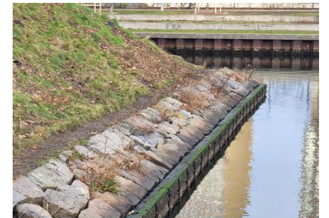
Figur 17. Glacis vid Bangårdskajen med synlig träspont.
