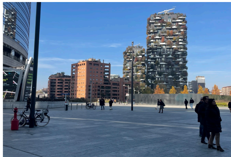
Bosco vertikale sett från ett närliggande torg (Alice Sandberg Oberdorfer, 2024).
