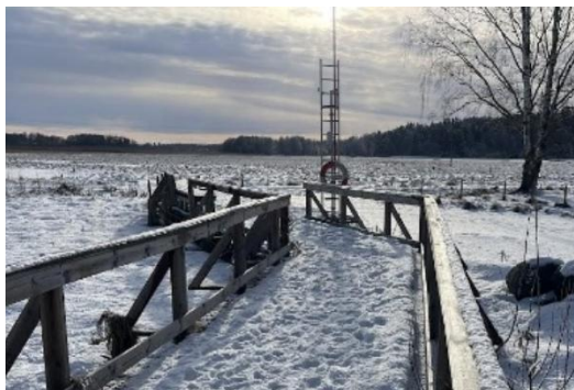
Figur 17. En utstickande del av däckspången är utrustad med livboj och stege vilket vittnar om att platsen kan bli mycket vattenmättad under vissa årstider. Etapp 1.
