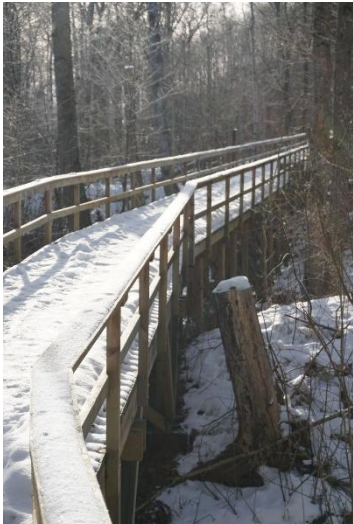
Figur 41. Spångens funktion är att underlätta framkomligheten i ett lutande landskap. Etapp 1.
