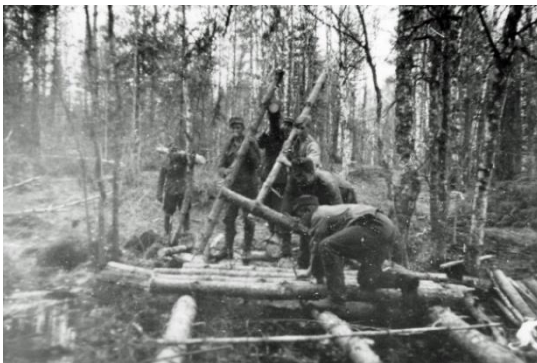
Figur 1. Kavelbro under byggnation (Hedlund, B (1941–1943). Bygge av kavelbro. [Fotografi] https://digitaltmuseum.se/0210111731510/bengt-hedlunds-minnesbilder [2026-03-03] PDM 1.0)
