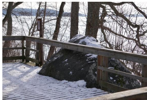
Figur 34. Spången har byggts runt och anpassats till stenens form. Etapp 5.
