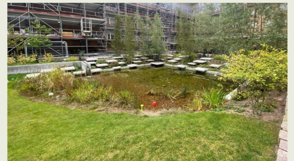
Figur 59. Inom "Framtidens innergård" i Straussvej finns en fluktuerande damm med stor kapacitet för skyfall på innergården. Sitt- och lekytor i betong är placerade runt dammen. © Jenny Hulthén, använd med tillstånd (2023).
