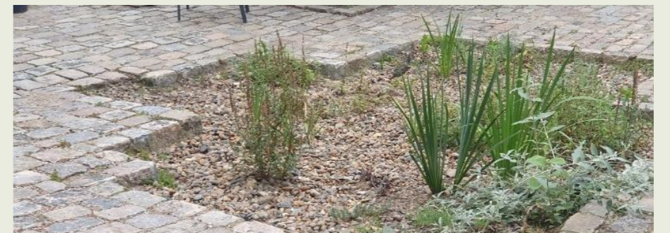
Figur 60. Fotografi inom "Framtidens innergård" i Straussvej på mindre nedsänkningar vilket fördröjer och synliggör dagvatten. © Siri Sandberg (2023).
