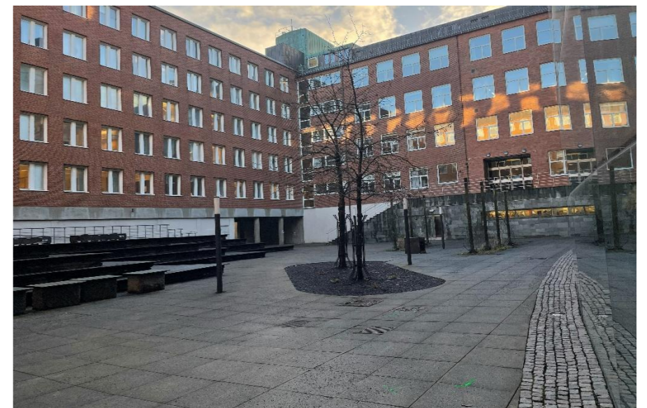
Figur 28. Innergården med pelarbelysning från det nordvästra hörnet (2025-12-01).
