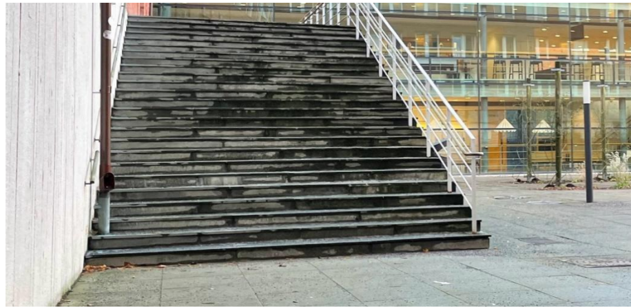
Figur 22. Ett av stuprören på innergården. Stuprören kan både på- och fränkopplas till ledningssystemet.
