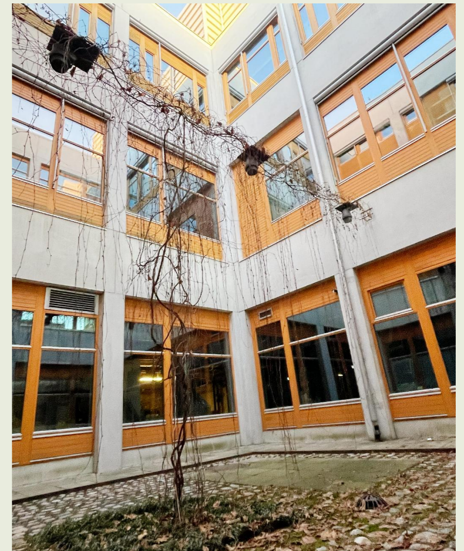
Figur 51. Foto av en liten och skuggig innergård inom Ultuna VHC. Vildvin upphängt i vajrar bildar en tredimensionell grön gardin och trots väldigt begränsad markyta och ljusinsläpp skapas en stark rumslig och visuell identitet genom gestaltningen av den vertikala vegetationen.
