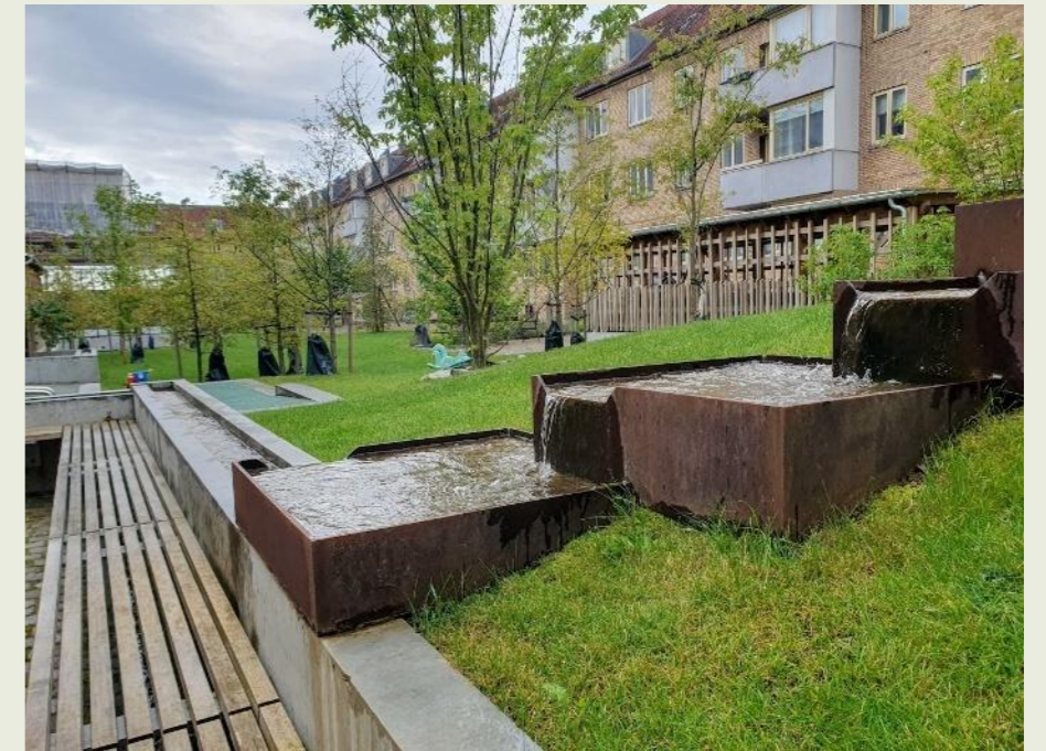
Figur 58. Vatten fördröjs genom kärll av cortenstål, innan det fortsätter vidare till en ränna inom "Framtidens innergård" i Straussvej.
