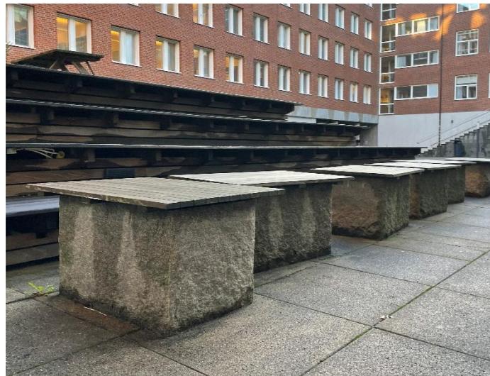
Figur 18. Stenblock med träpanel på innergården. Dessa verkar inte vara fastmonterade.
