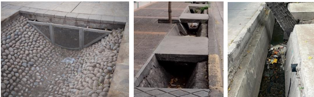
Figur 7. Foton som visar de tre vanligaste typerna av acequias . Från vänster visas den helt hårdlagda acequias typ 1, i mitten typ 2 och till höger typ 3 som båda är delvis hårdlagda Bild: Agnes Englund
