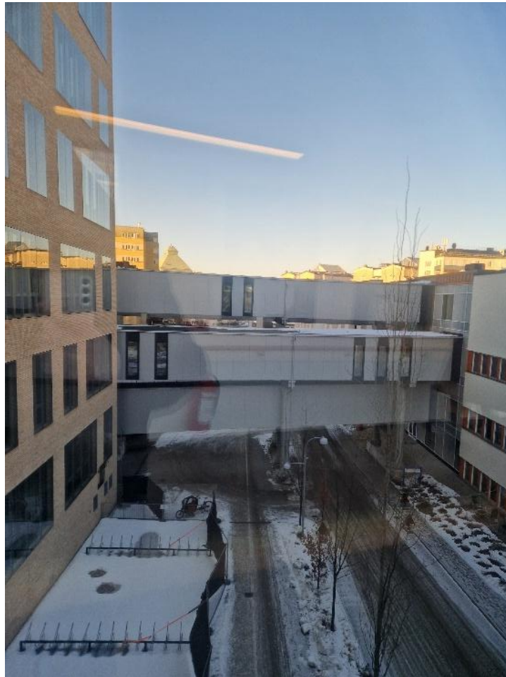
Figur 21. Mellan Ingång 100 och Ingång 85 finns en gångtunnel som utblickar över en av transportvägarna runt sjukhuset. Vägen kantas av buskage och pelarformade träd och utgör naturliga utblickar för de fasader som kantar vägen. (Wallström, A (2026) [Fotografi])
