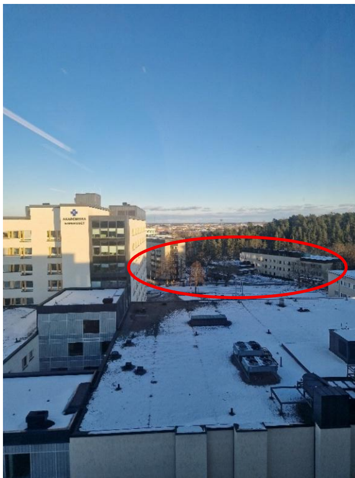
Figur 17. Utsikten från ett kontor med likvärdig utsikt från Ingång 100. Rummet ligger på våning sex och vetter i östlig riktning. Fotot är taget från stående läge då liggande läge inte var möjligt. (Tillägg av: Pfeiffer, K. (2026) Underlag: Wallström, A. (2026) [Fotografi])
