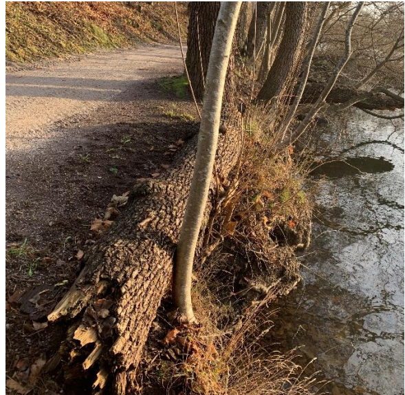
Figur 17. En stock med levande träd som stöd fungerar som erosionsskydd längs Motala Ström i Norrköping. (Eriksson 2025).
