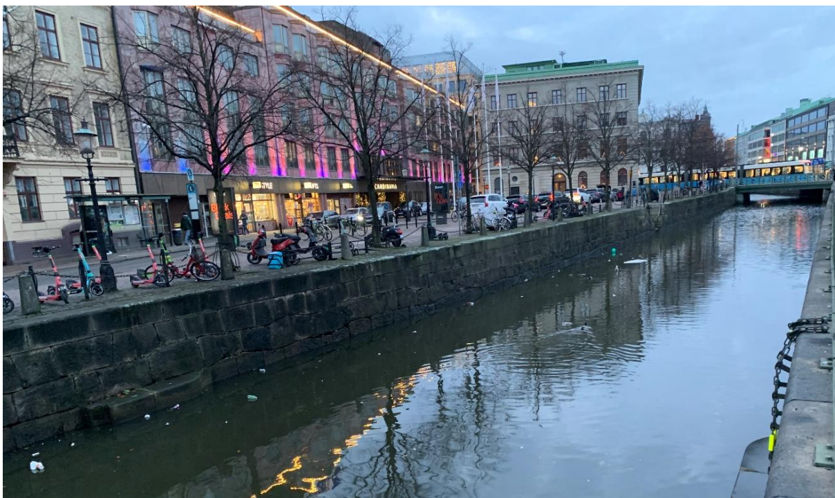
Figur 28. Stödmurar längs kanalen i Göteborg (Eriksson 2025)
