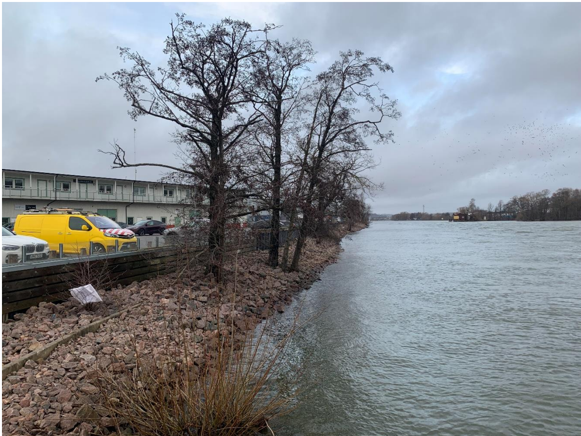
Figur 37. Alar i stenskning längs Göta Älv i Göteborg (Eriksson 2025)
