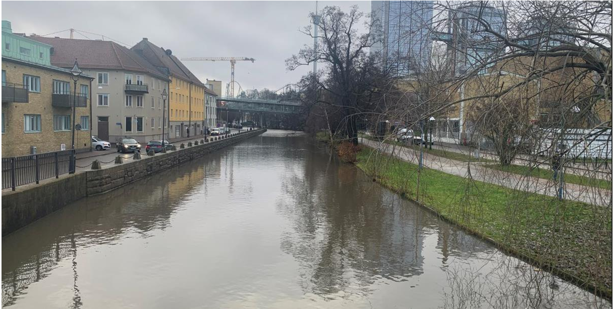
Figur 26. Mölndalsån i Göteborg. Stödmur av betong på sidan av ån med biltrafik och byggnader nära vattnet. Spont av trä på sidan av ån med vegetation och cykelbana nära vattnet (Eriksson 2025)
