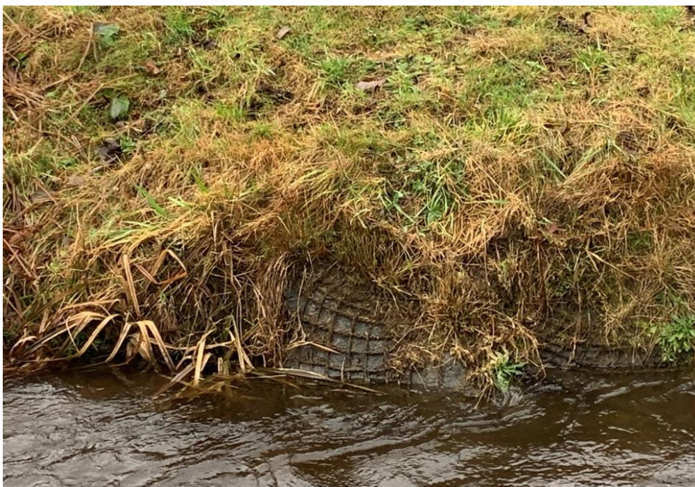
Figur 32. Bild från Mölndalsån i Mölnlycke. Geonät håller fast stenar under gräs och örtvegetation (Eriksson 2025)
