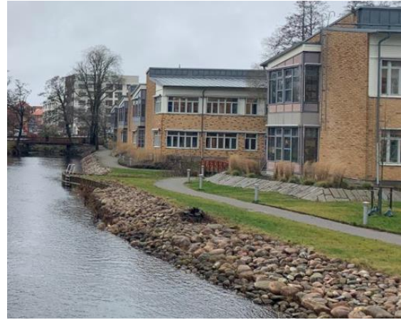
Figur 24. Stenskoning längs ena banken vid Mölndalsån i Mölnlycke (Eriksson 2025)
