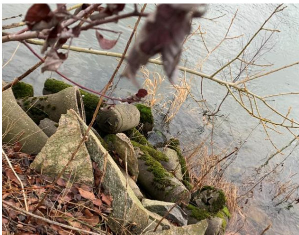
Figur 25. Betongskrot fungerar som stenskoning vid Göta Älv (Eriksson 2025)
