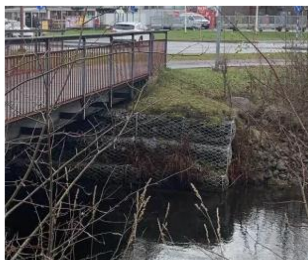
Figur 30. En vertikal konstruktion med gabioner staplade på varandra under en bro, Mölndalsån i Mölnlycke (Eriksson 2025)
