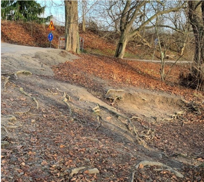
Figur 12 Foto som visar en eroderad slänt i banken längs Motala Ström i Norrköping. Här är det bara rötter som hindrar slänten från värre erosion. Till vänster i bild ser man även att kanten till gångbanan nyligen kompletterats med stenmjöl. (Eriksson 2025).
