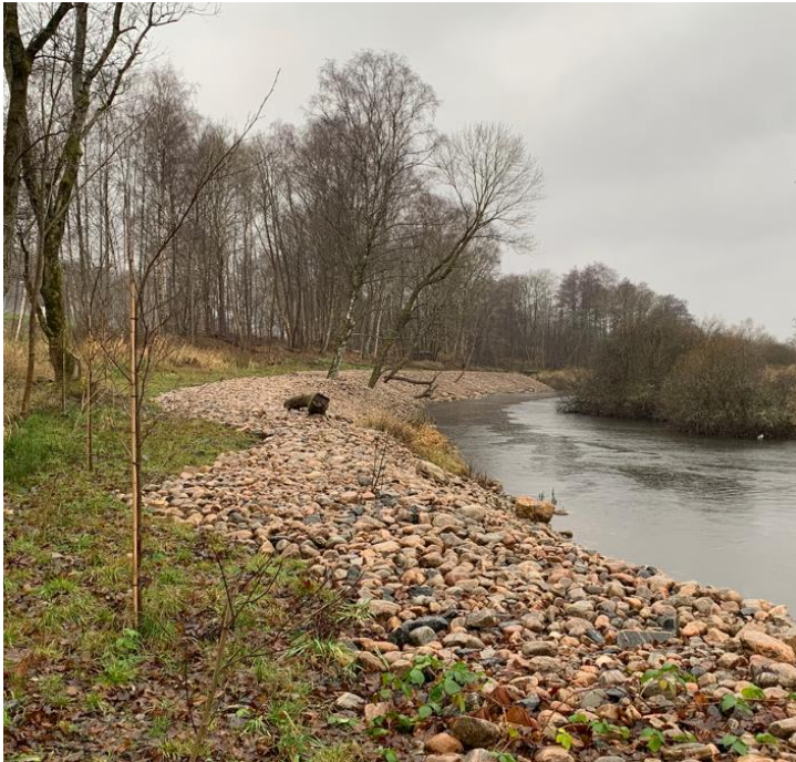
Figur 35. Nyligen anlagd stenskning med växter längs Säveån vid motorvägen i Partille (Eriksson 2025)
