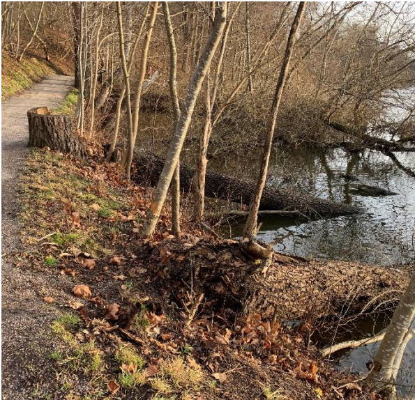
Figur 16. Döda stammar placerade med basen på land och toppen ut i vattnet kan sänka flödes hastigheten längs banken och skydda mot erosion. Foto från Motala Ström i Norrköping. (Eriksson 2025).
