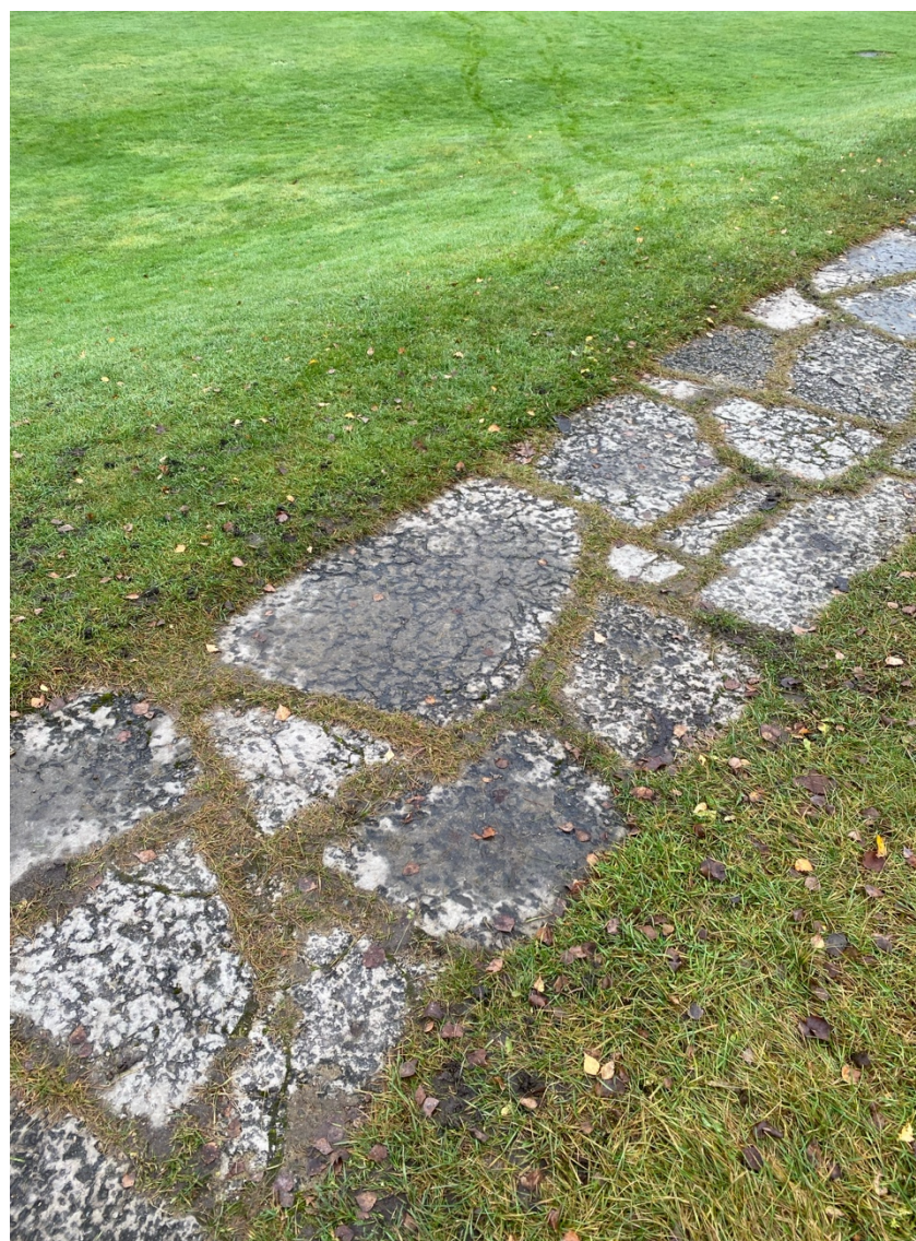
Figur 25: Gång av natursten vid Heliga korsets kapell .
