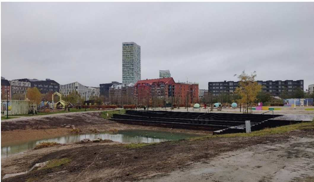
Figur 6. Bilden visar samma vy som visionsbilden. Bilden är tagen vid platsbesök den 11 november 2025. Markarbete pågår i dammens sluttningar. Cafét och växthuset har inte tillkommit, i stället finns här en beachvolleybollplan.
