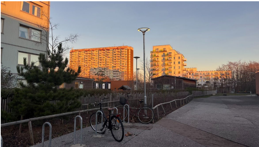
Figur 12. Efterbild på samma yta som i figur 11 med förändringar efter byggnation, Lindängeskolan (Dana Alaqrabawi, 2025)
