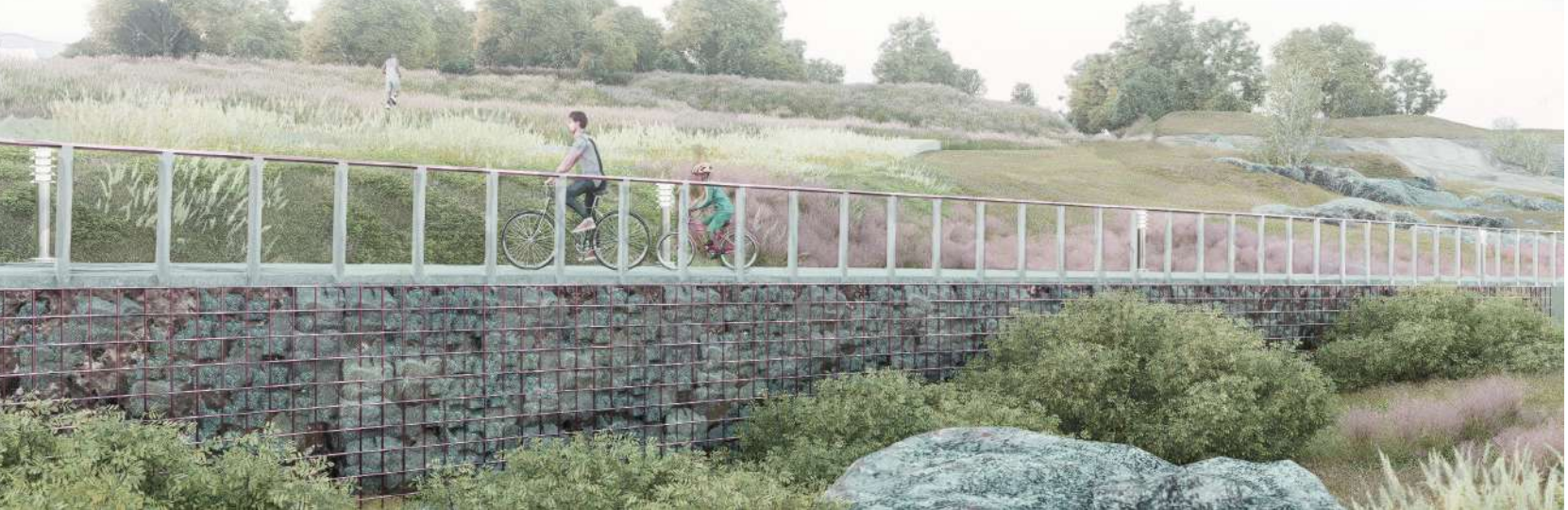
Gång- och cykelvägen ner mot Strandpromenaden villar på gäbionmurar fyllda med återbrukat krossmaterial från tunnelbygget och blir ett element som berättar om platsens omvandling. Räcket kombinerar stölpår i naturen med detaljer i stål.
