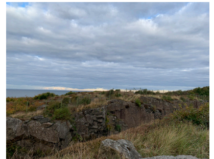
Bergskärningen på Hästtagaberget.
