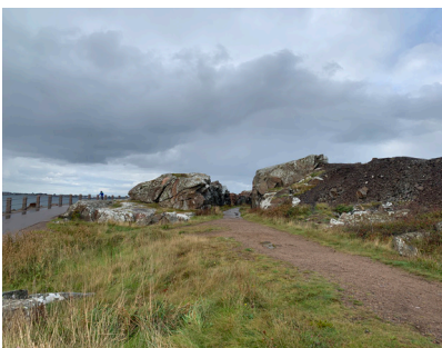
Den äldre banvallen från 1885 sedd från söder.
