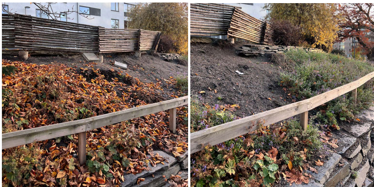
Figur 55–56. Lutande plantering med stora partier bar jord. Slitage kan bero på erosion, bristande växtval och etablering samt torra växtbäddsförhållanden snarare än direkt tramp.
