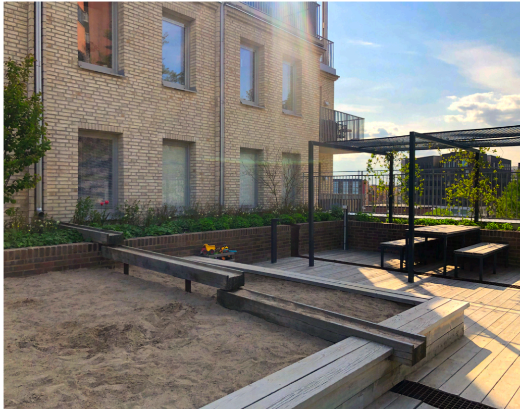
▲ Figur 16. En trappad ränna gör dagvatten från taket tillgängligt för lek i sandlådan men fortsätter förbi för senare infiltrering.
