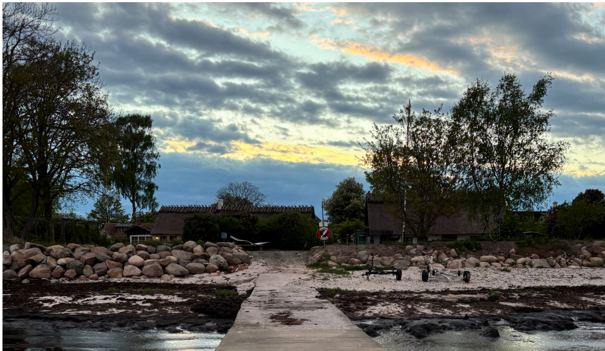
Figur 9. Ett hårt skydd mot kusterosion i form av strandskoning, här den 17 maj 2025 i byn Örnahusen i Simrishamns kommun. Fotografi: C. Petersson, 2025.
