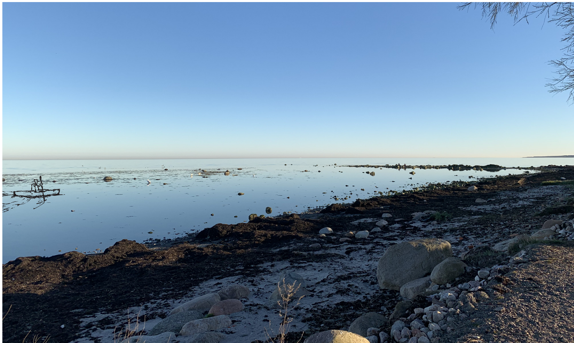
Figur 37. Fotografi av Örnahusens strandskoning, här den 19 april 2022, då stora delar av den dragits med ut i havet och det gjordes försök till att laga den. Fotografi/illustration: C. Petersson, 2022.
