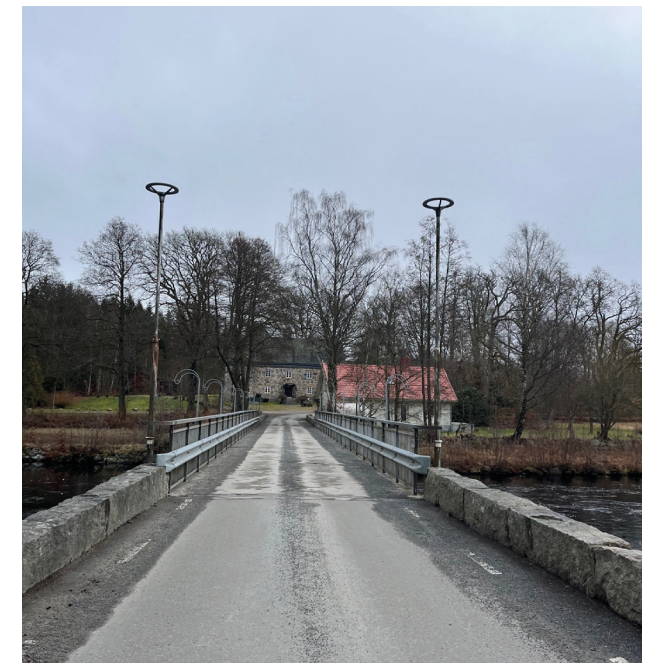
Fig 48. Den enkelriktade bron är enda övergången mellan Östanå och Hemmestorp.
