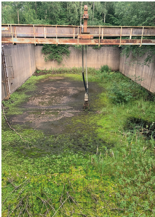
C) Grönskan tar över i den gamla sedimenteringsbassängen.
