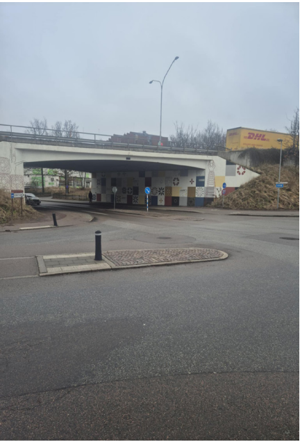
Vy 2. Entré med målad tunnel.
