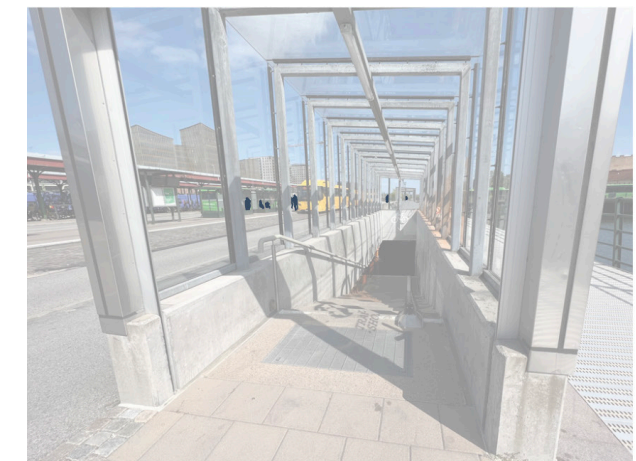
Figur 58. Trappa ned till cykelgarage
