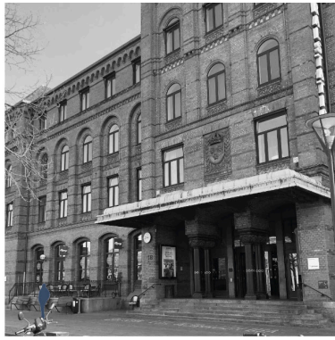
4. Otillgänglig trappa, utan ramp. Uteserveringar med staket.
