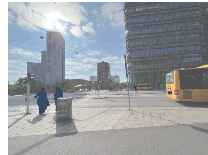
Figur 61. Exempel på storskalighet, bilism och fasad med få öppningar.
