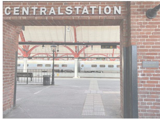
Figur 57. Entré till banhallen
