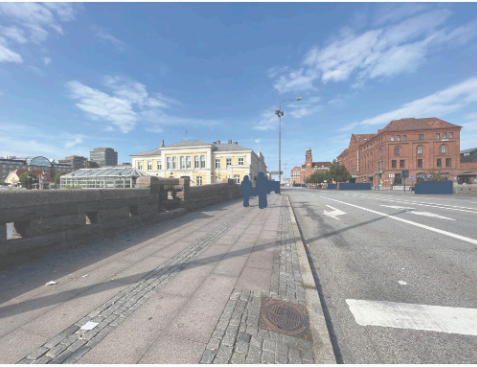
C. Mälarbron m gatan Skeppsbron.
