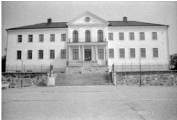
Figur 67. Fotografiet visar hur flygelgården ser ut efter renoveringen på 1960-talet, fotot är taget 1985.
