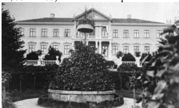
Figur 49. Järnställningen på fundamentet i mitten på flygelgården. Taget 1878-1900.
