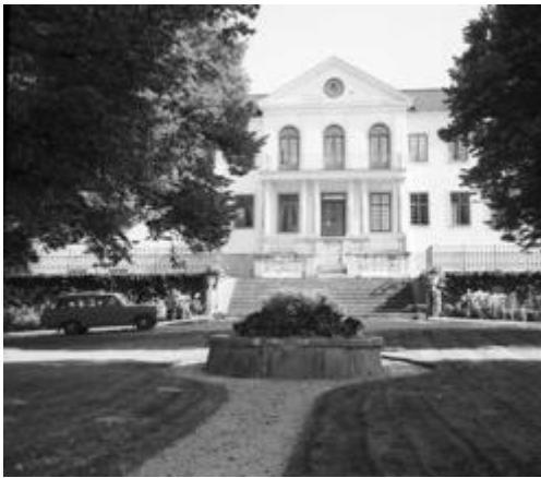
Figur 64. Flygelgården innan den görs om 1964. Ser fundamentet i mitten utan järnställning, planteringar längs stenterrassen och gräsmattorna.
