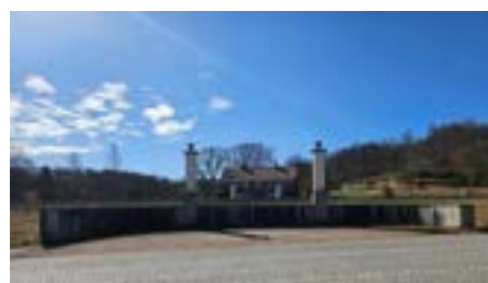
Figur 23. Murarna med pelare på vardera sida av motorvägen. I bakgrunden syns Lilla Nääs.
