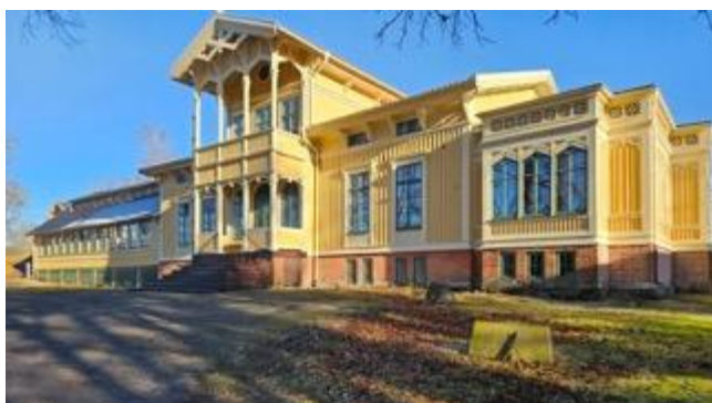
Figur 6. Värnhem är en av de stora träbyggnader som är en del av slöjdseminariet.
