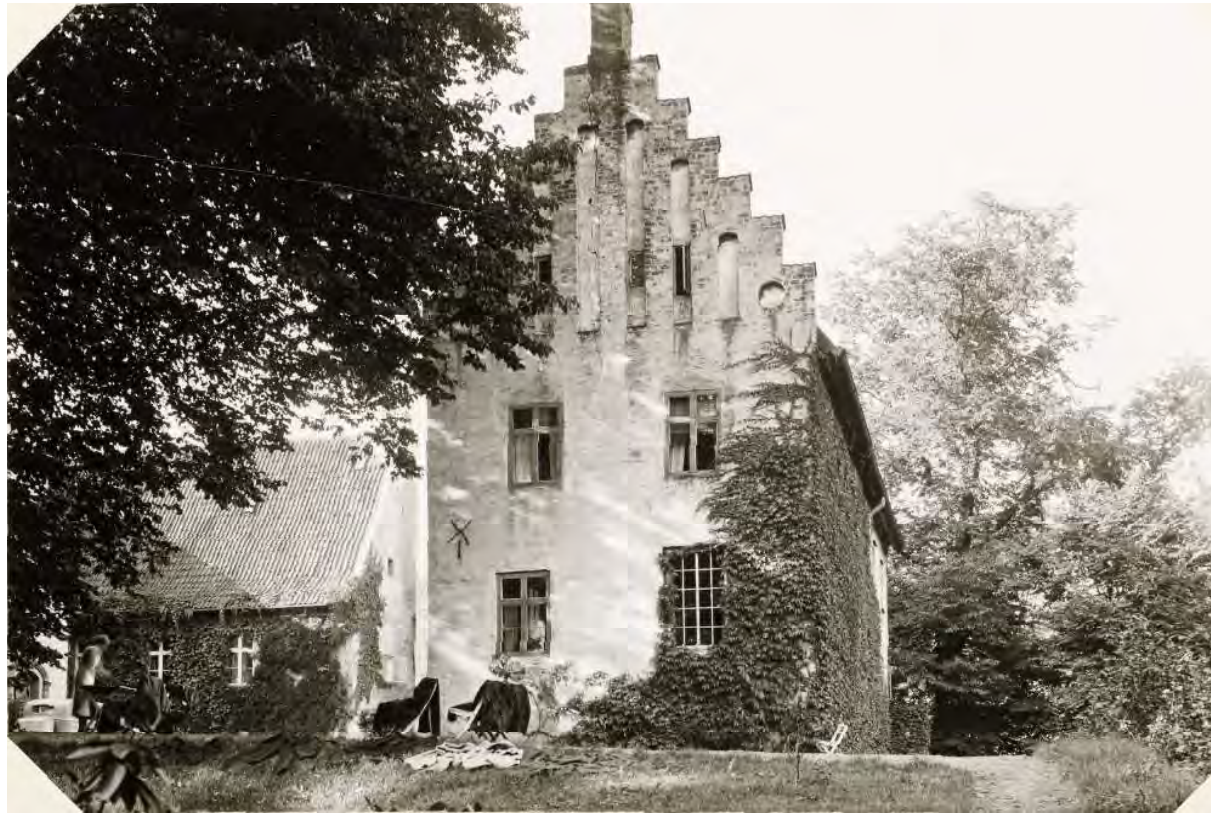
Figur 82. Fotografi från 1935. Den gräsbeklädda slänten intill borggården i söder, på vilken kläder tycks ligga ute på blekning. Till höger i förgrunden syns stigen som ledde ner till den försänkta gräsparterren. (Sjöbeck 1935)
