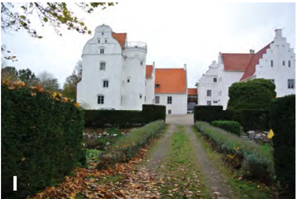
Figur 51. Den södra bron till borggården, kantad av lavendel. November 2024.
