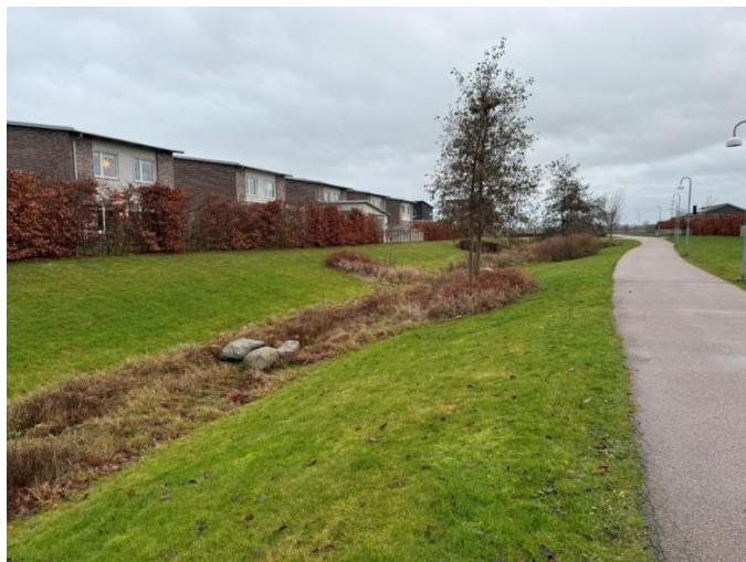
Figur 30. Visar halva svackdiket i riktning mot norr, varierad vegetation och större stenar med flacka kanter.
