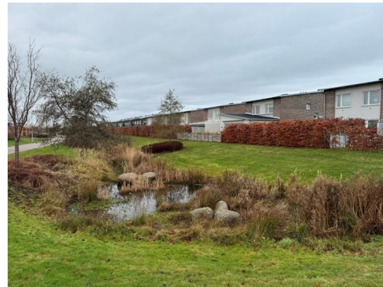
Figur 31. Visar svackdikets norradel med en vattenspegel, varierad vegetation och större stenar samt flacka kanter.
