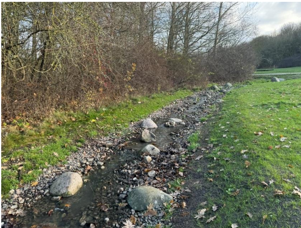
Figur 53. Grundare sektion av vattensystemet med lösa mindre stenar.
