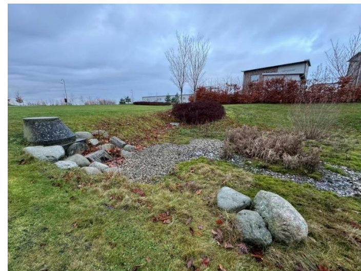
Figur 32 Visar svackdikets sydligaste del med utloppet till vänster i bild, varierad vegetation och större stenar.
