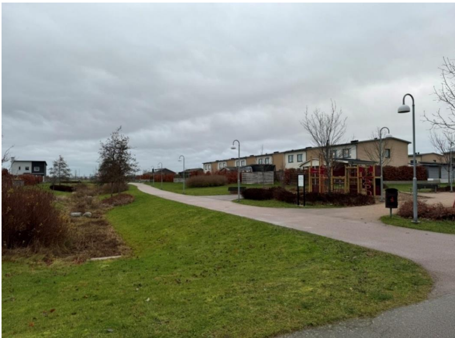
Figur 24. Till vänster i bild den norra delen av svackdiket och till höger i bild lekplatsen.
