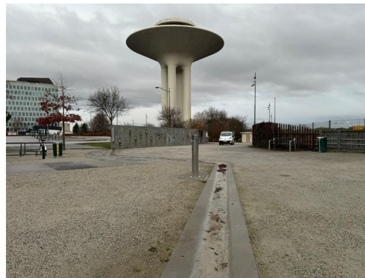
Figur 36 Ränn dalen fortsätter ner längs en lutning med bortmonterade vattenarmaturer.
