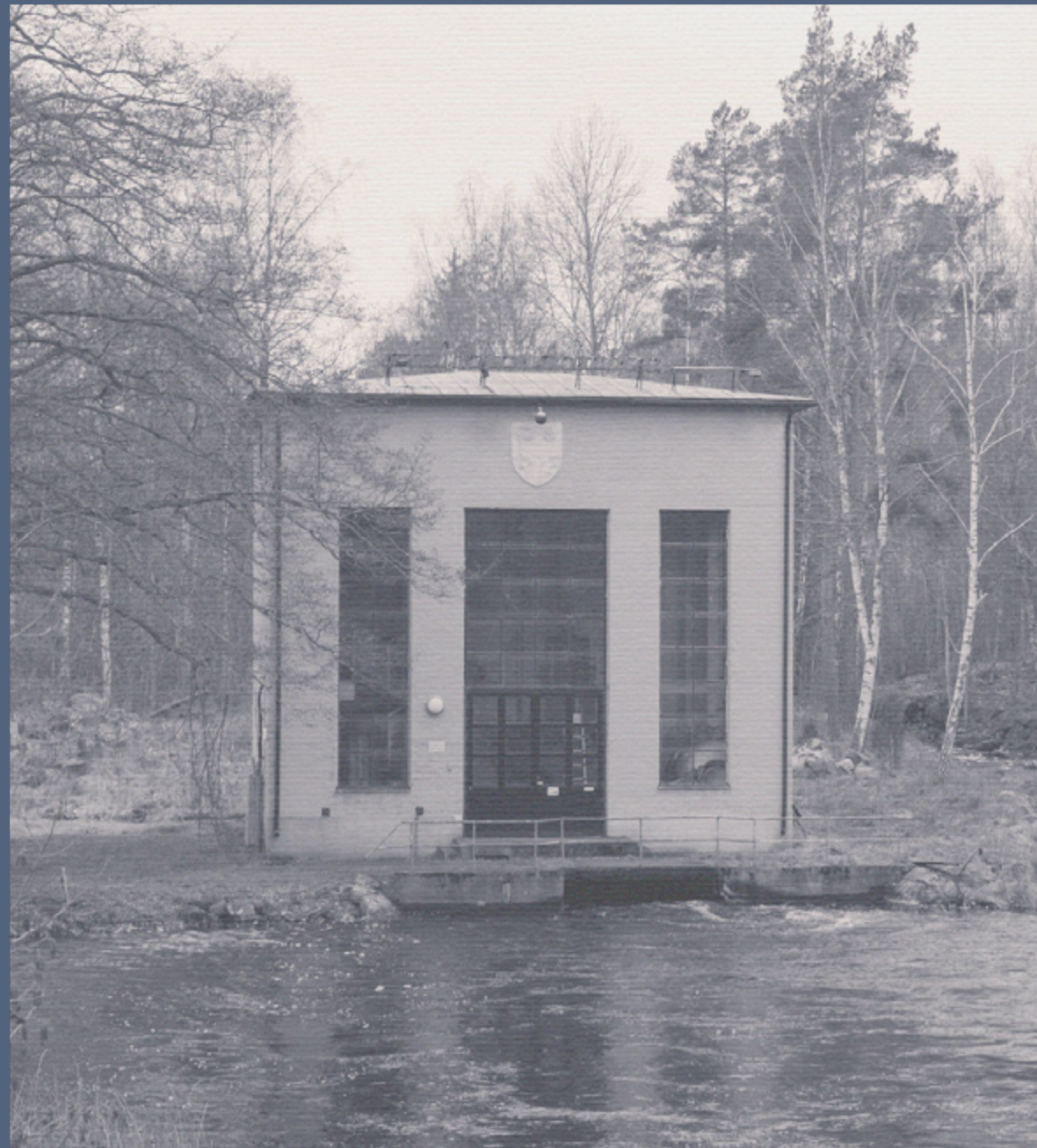
Figur 11. Fröseke kraftverk upprättat omkring 1940 är idag en av flera historiskt värdefulla byggnader kring Älghult
