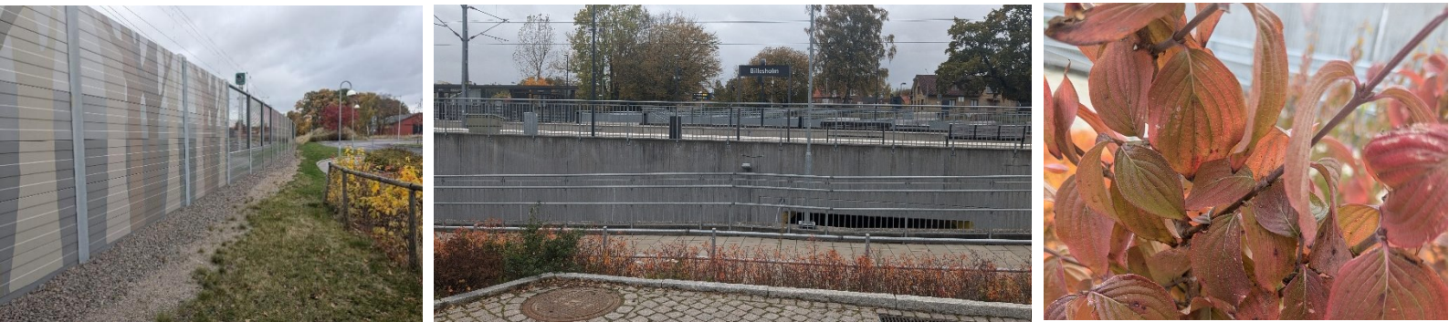
Bild 9. Till vänster Kågeröd, där ett gestaltat bullerplank med naturmönster i avskärmar mot spårområdet. Till höger två foton från Billesholm som i stället har använt stålstaket mot spåret, där finns även långsmala rader med likartade planteringar. Foto: J. Lassvik 2024.
