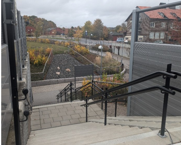
Bild 10. Kågeröd till vänster och Billesholm till höger. Till vänster ses målade ledstänger och till höger ledstänger och staket i galvaniserat stål. Foto: J. Lassvik 2024 (t.v.) samt S. Bodelius 2022 (t.h.).
