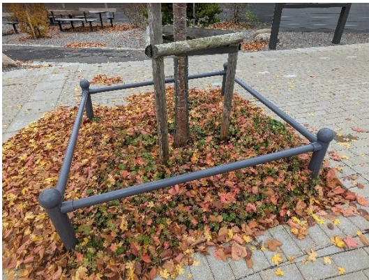
Bild 18. Omhändertagande av dagvatten. I Kågeröd till vänster, ses ett yngre träd vars växtbädd saknar kantsten så att regnvatten kan infiltrera växtbädden. Till höger är ett linjeavvattningsgaller i Billesholm. Foto: J. Lassvik 2024.
