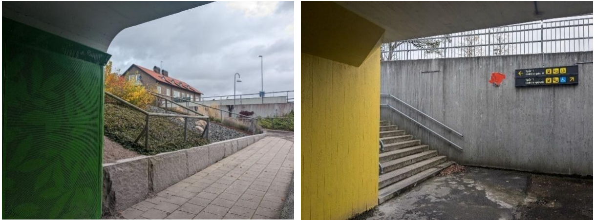
Bild 12. Gestaltning av uppgång. Kågeröd till vänster, Billesholm till höger. I Kågeröd leder utformningen av tunnelanslutningen till ljusinsläpp och att trafikanterna får en överblick över miljön. Gångbanan i Kågeröds tunnel är belagd med marksten medan cykelbanan är belagd med asfalt. I Billesholm är både gång- och cykelbana belagd med asfalt och trafikanter ser inte mycket av vad som sker utanför tunnelns entré. Foto: J. Lassvik 2024.
