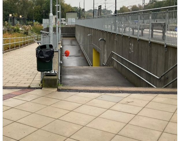
Bild 10. Kågeröd till vänster och Billesholm till höger. Till vänster ses målade ledstänger och till höger ledstänger och staket i galvaniserat stål. Foto: J. Lassvik 2024 (t.v.) samt S. Bodelius 2022 (t.h.).
