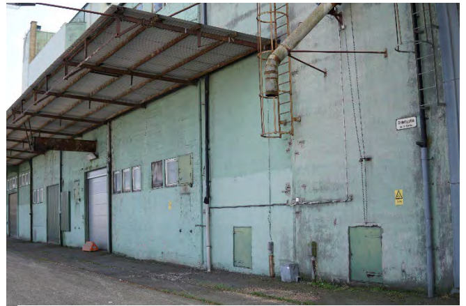
Figur 13. Industribyggnader som finns på området.
