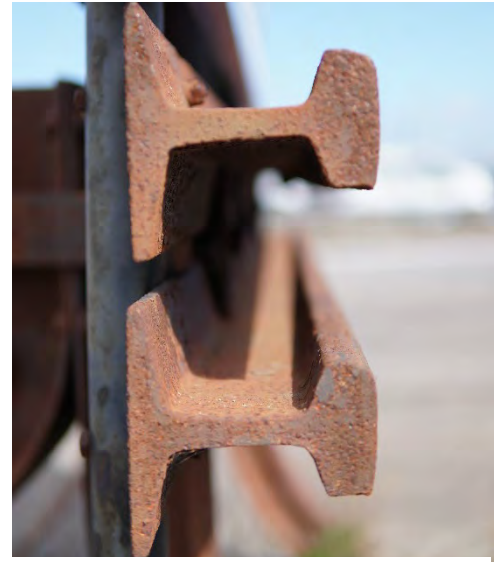
Figur 9. Stålbjälkar från industrin. Dessa kommer användas som rabattkanter och sitttytor i gestaltningen.
