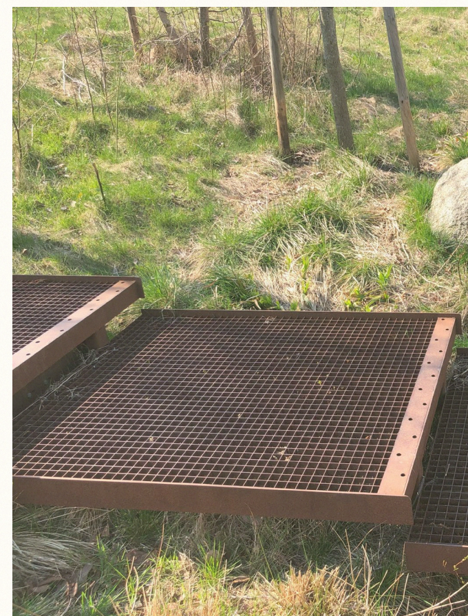
Figur 20. Trappa i cortenstål, Remiseparken, Köpenhamn. Foto: Lisa Wikström.
