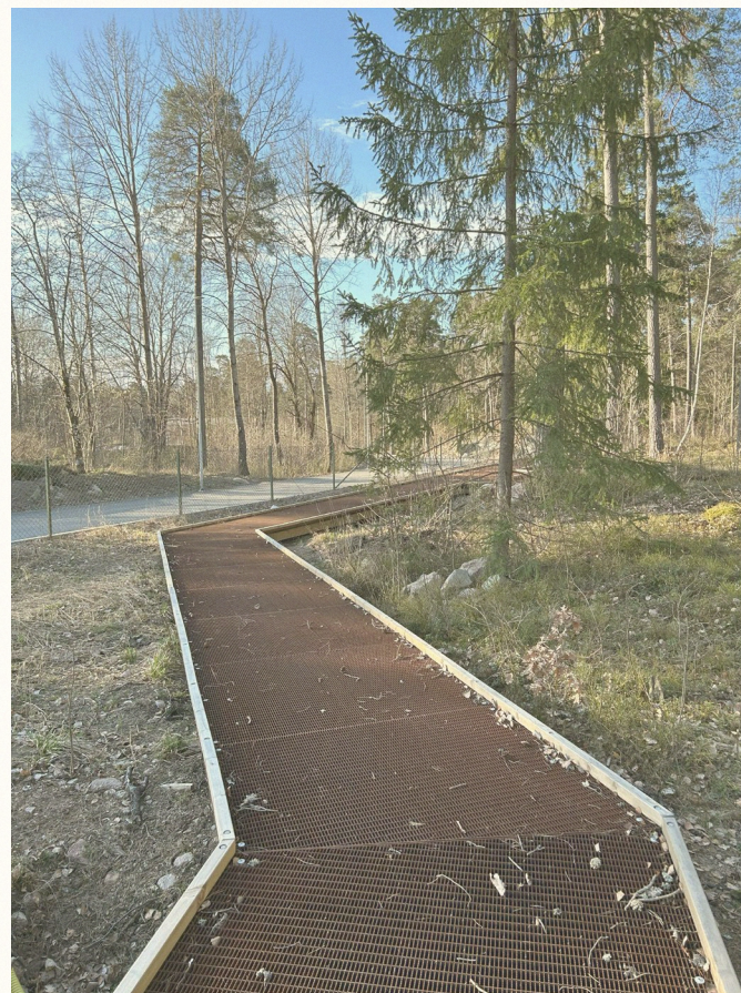
Figur 19. Spång av Cortenstål i Ulleråker, Uppsala.
