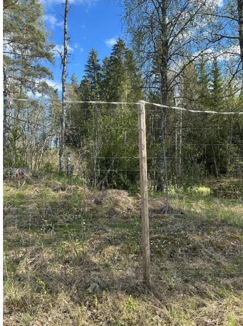
Figur 3. Stolpe gjord av tryckimpregnerat trä. Den mest använda typen av stolpe vid konstruktion enligt standardmetoden. Foto: Emma Arnesson.
