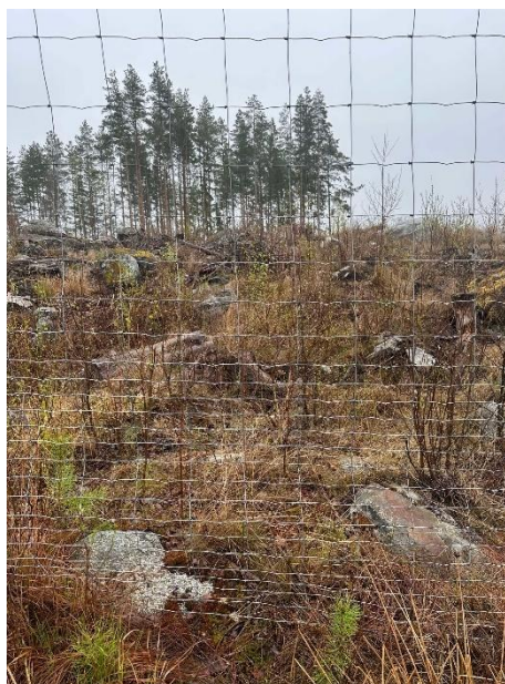
Figur 2. Viltnät med vridknut, med mindre maskor nedtill. Foto: Emma Arnesson
