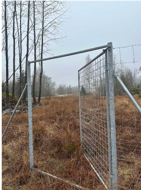
Figur 5. Visar en självstängande grind gjord av stål. Foto: Emma Arnesson.
