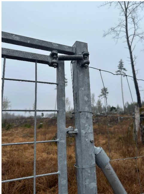
Figur 7. Visar en självstängande grind utrustad med en fjäder. Fjädern är placerad uppe i högra hörnet av grinden. Foto: Emma Arnesson.
