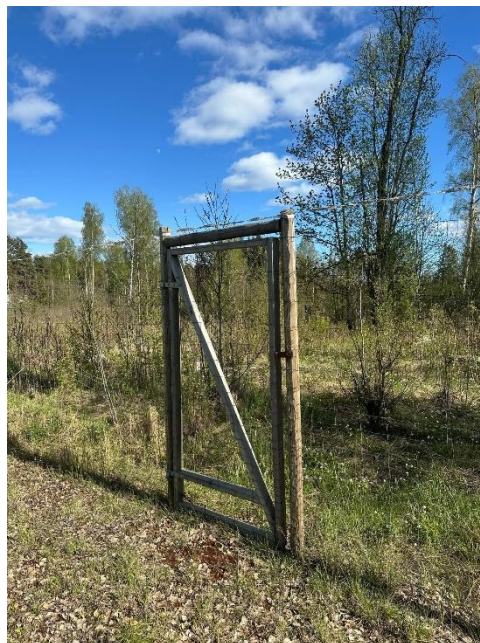
Figur 6. Visar en grind gjord av tryckimpregnerat trä. Foto: Emma Arnesson.
