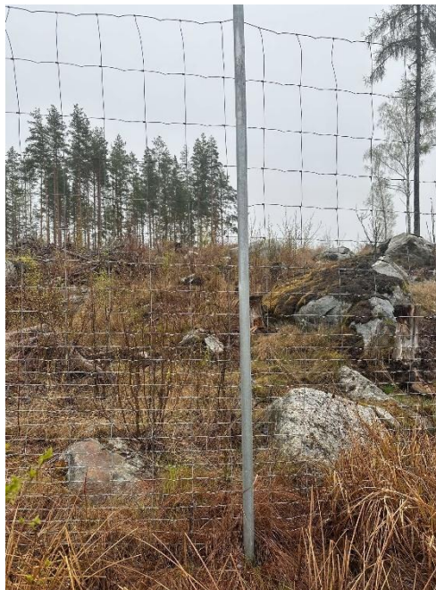
Figur 4. Stolpe av stål, som används i enstaka fall. Foto: Emma Arnesson
