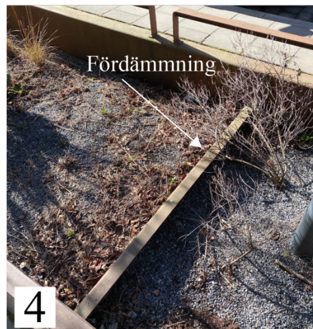
Figur 37. Bilder från platsbesök på Taxgatan. Bilderna visar inlopp från gatan, bräddningsbrunnen som ser till att vattnet inte svämmar ut ur regnbädden, brunnen på lokalgatan som leder vattnet till regnbädden och fördämningen som stoppar upp vattnet.
