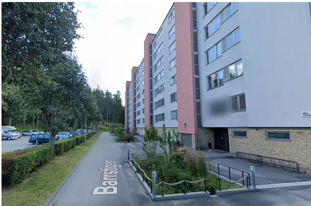
Figur 39. Gatuvy över regnbäddarna på Barrstigen (Google maps 2025). Det går att antyda det höga berget på vänster sida samt hur det är stora mängder asfalterad yta runt om regnbäddarna.
