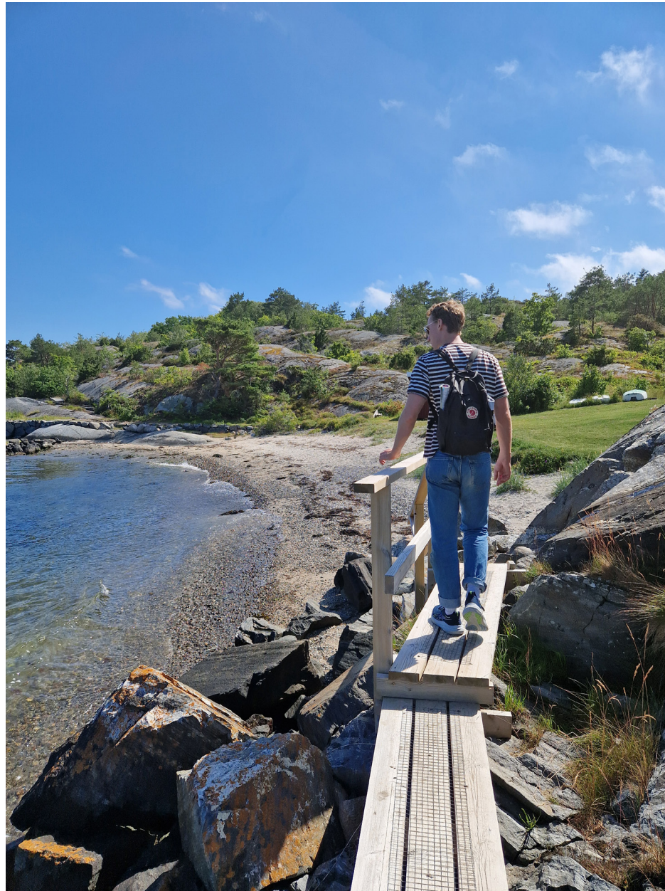
Fig. 40, En av träspångarna längst vandringsleden, Ekenäs, Koster. Spången är utformad med räcke, trappa samt halkskydd i form av nät.
