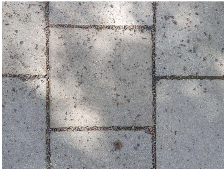
Figur 15, Betongmarksten med infiltrerande fogar. Foto: Simon Franzon
