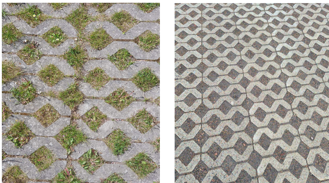
Figur 13 & 14, Till vänster: Infiltrerande gräsyta armerad med betongmarksten. Till höger: infiltrerande grusyta armerad med betongmarksten. Foto: Simon Franzon & Thomas Björnfors.
