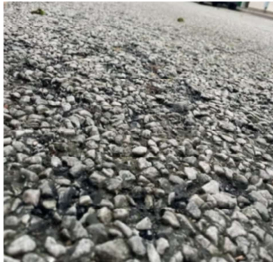
Figur 12, Slitlager av permeabel asfalt. Foto: Asrar Emad
