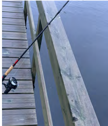
Figur 23. Skåra i handräcket för fiskespö.
