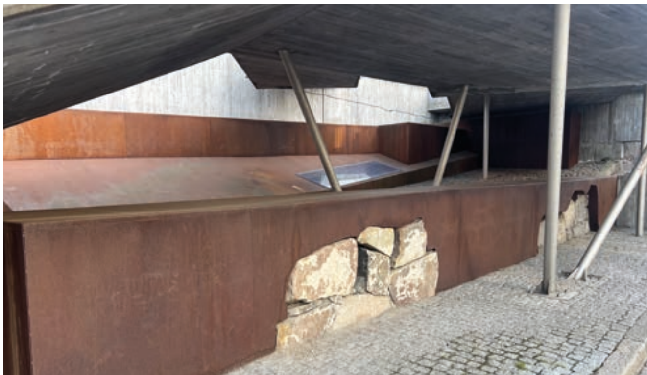
Fig. 57. Muren som lyftes fram i gestaltningen under trappan.
