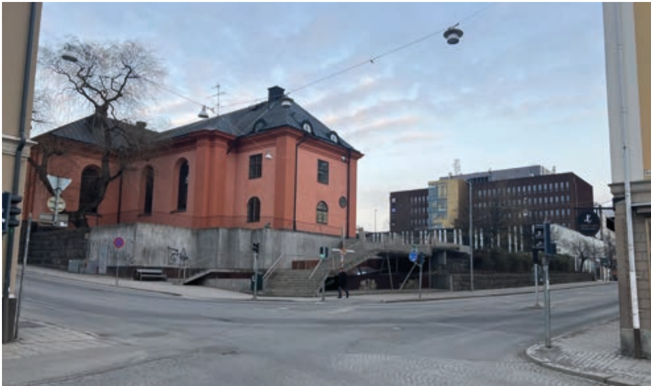
Fig. 55. Fotot är taget mot Hörsalsparkens nordvästra hörn. Trappan är väl synlig och öppen mot båda håll. Under trappan kan man skimta cortenstål och de gamla framgrävda murarna som sparats.
