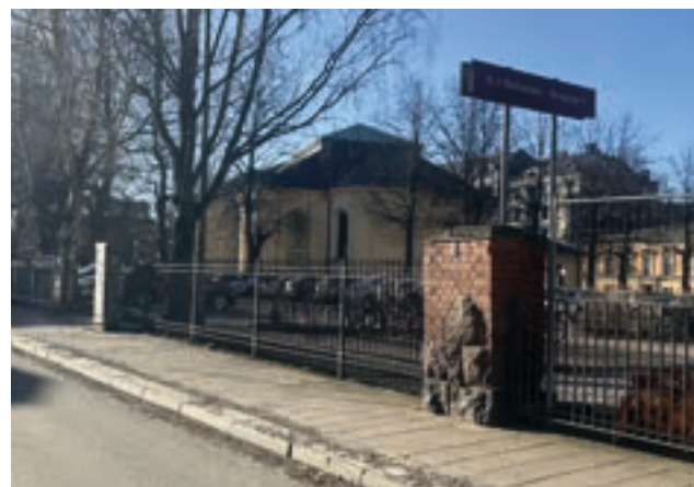
Fig. 78. Foto från idag där stolparna till staketet är kvar.
