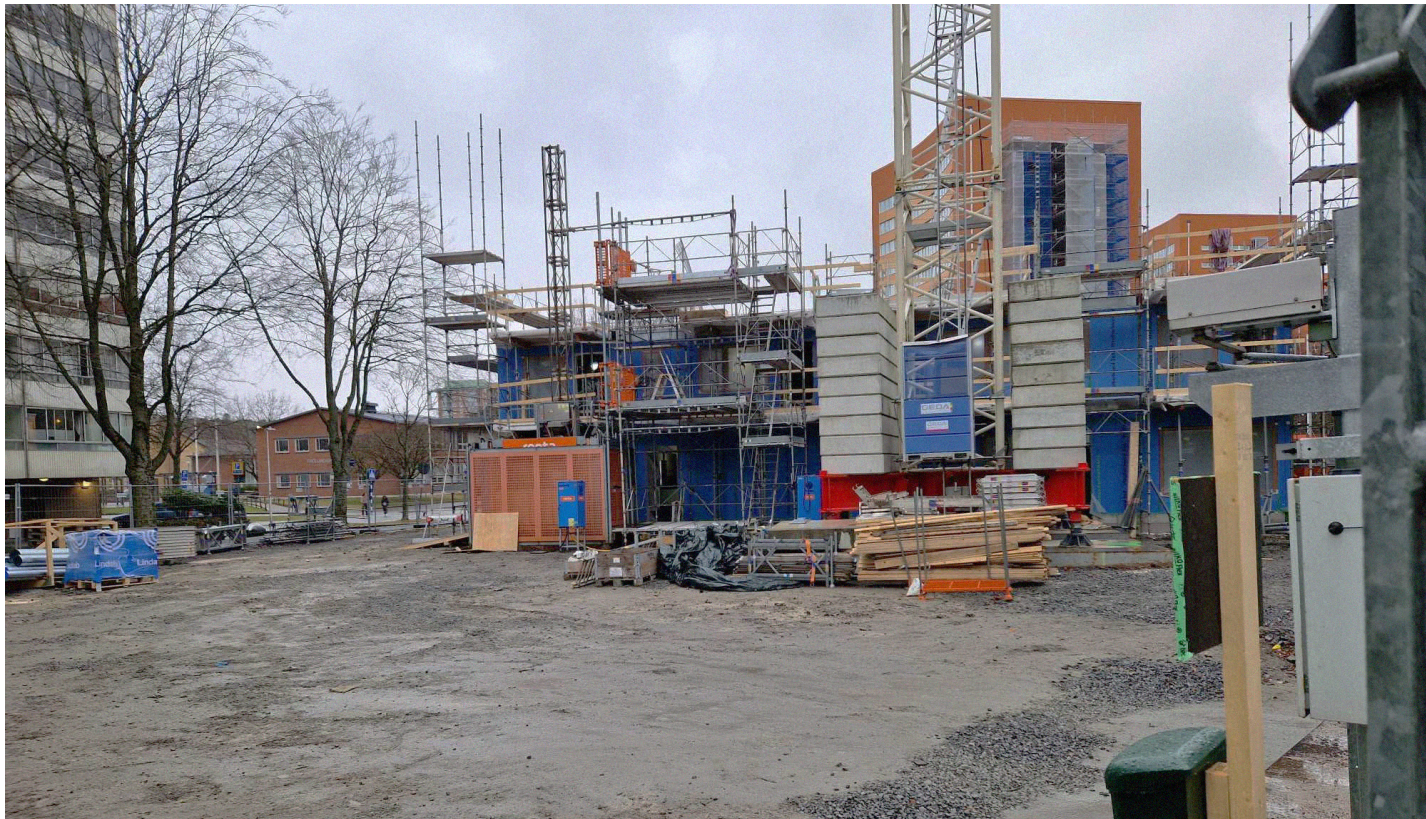
Utveckling. I Västra Frölunda pågår nu ett fortsättningsprojekt, där den nya visionen är att skapa en blandstad. Byggställningar är ett återkommande inslag i den nya stadsbilden som en ständig påminnelse om förändring.
