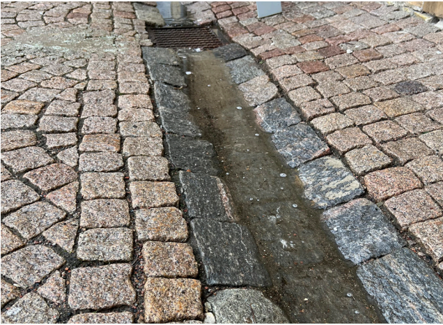
Diskret ränna i markmaterialet för dagvatten
