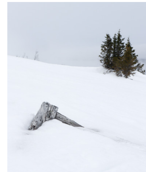
Figur 17. Rester av ett tidigare snöstaket sticker upp ur snön.
