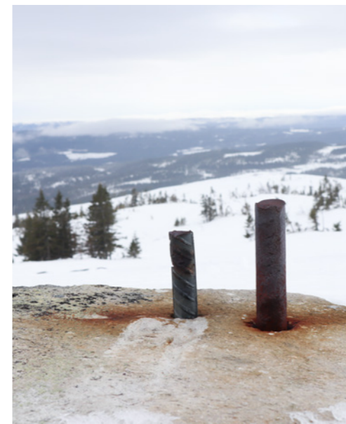
Figur 16. Förankring i fjället.
