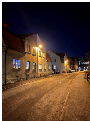
Bild 65. Belysning av bostadsgata på gränsen mellan gamla stan och nyare område i Ystad, där armaturen är ca 6 m hög, 64 LUX och ett spillljus hög, 50 LUX och ett ljus som direkt påverkar bostäder där den är placerad.
