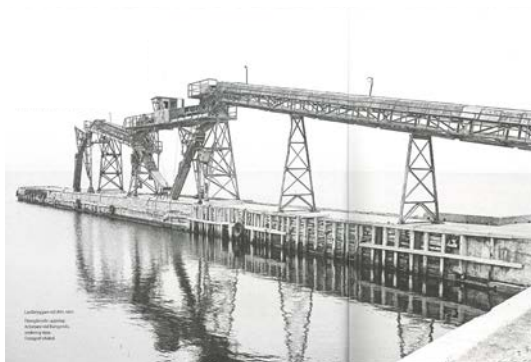
Fig. 23. Den cirka 100 meter långa lastbryggan vid den gamla hamnen var ett tydligt element i landskapsbilden med sin kontrasterande riktning. Även stålkonstruktionerna var påtagliga objekt i landskapet.
